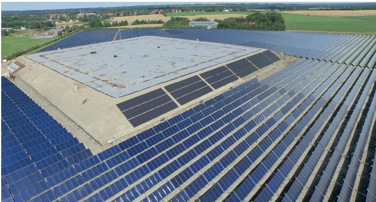
Solarthermiekollektoren und Erdbecken-Wärmespeicher in Gram, Dänemark
